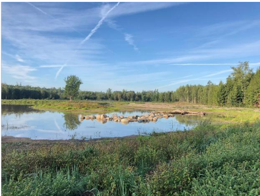
Bild 26 Exempel på dagvattendamm från Björnöckärr i Kalmar (Vatten- och samhällsteknik, 2022-10-11)
