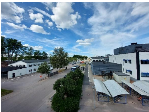
Bild 25 från viadukten mot Ikea 4
