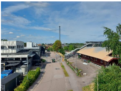
Bild 23 från viadukten mot Västergatan
