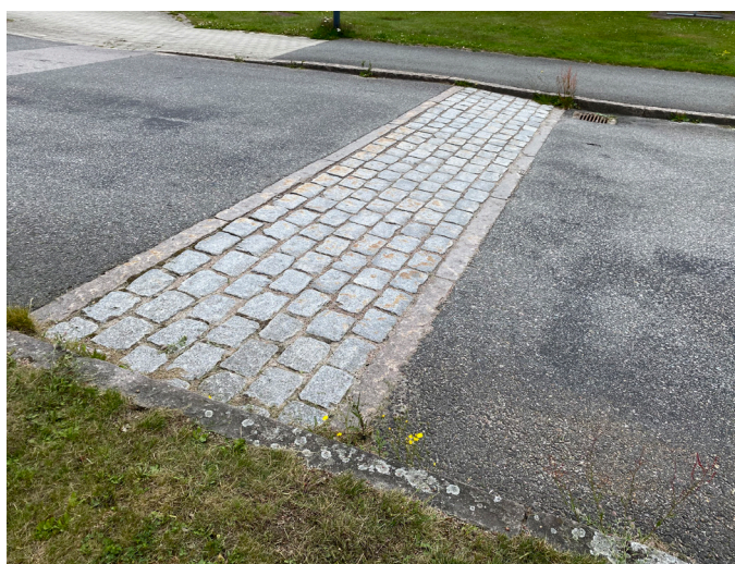
Bild 16. Farthinder på Östra Esplanaden i Älmhult där rampen är i smågatsten som ramas in med granitkantsten. Farthinder vid övergångsställe B ska utformas på motsvarande sätt. Referensbild.
