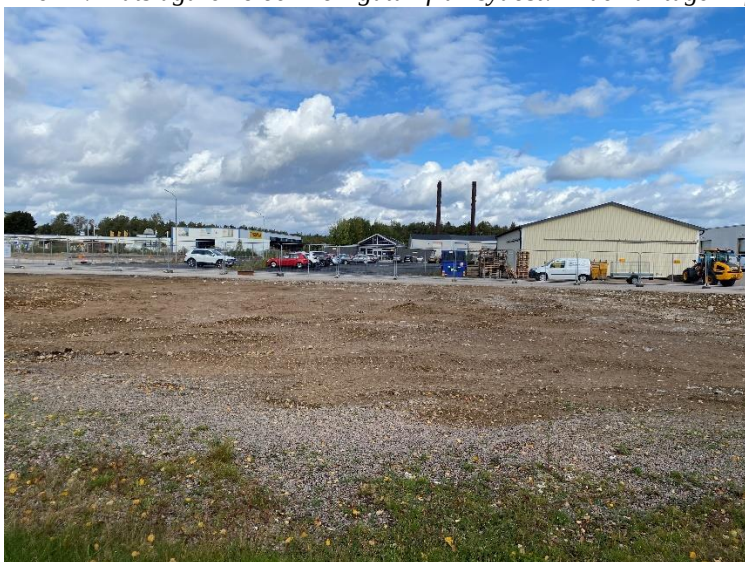
Bild 25. Plåtslagaren 6 efter rivning av byggnader. Bilden är tagen i september 2024.
