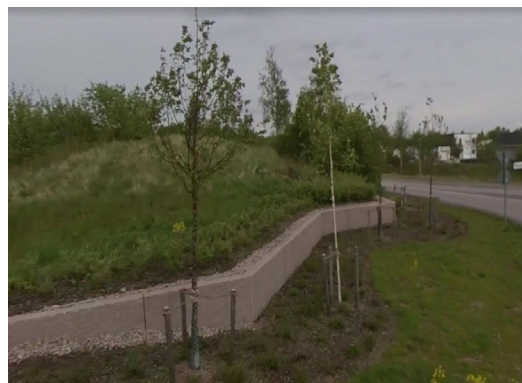
Bild 6. Granitmur vid infart till Västra Bökhult.
