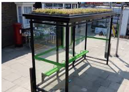
Bild 4. Väderskydd med sedumtak vid busshållplats
