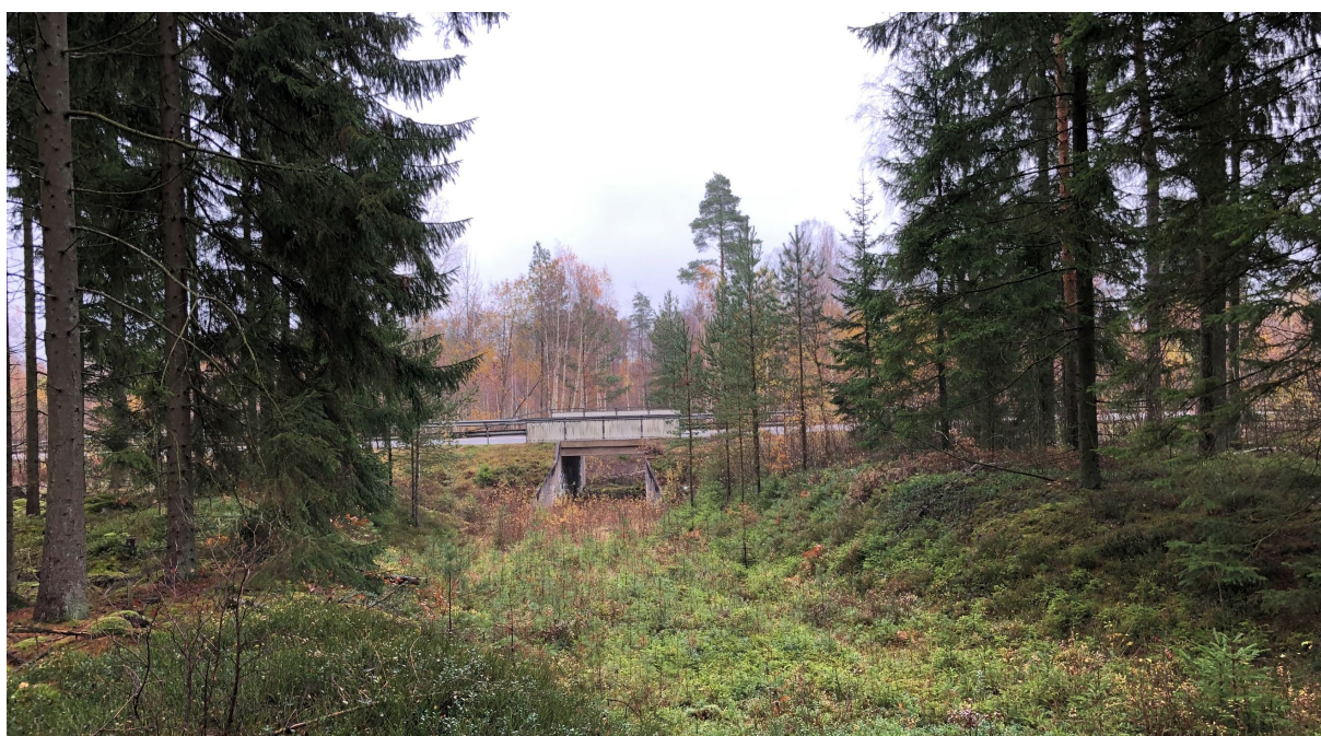
Bild 26. Befintlig tunnel under Danska vägen.
