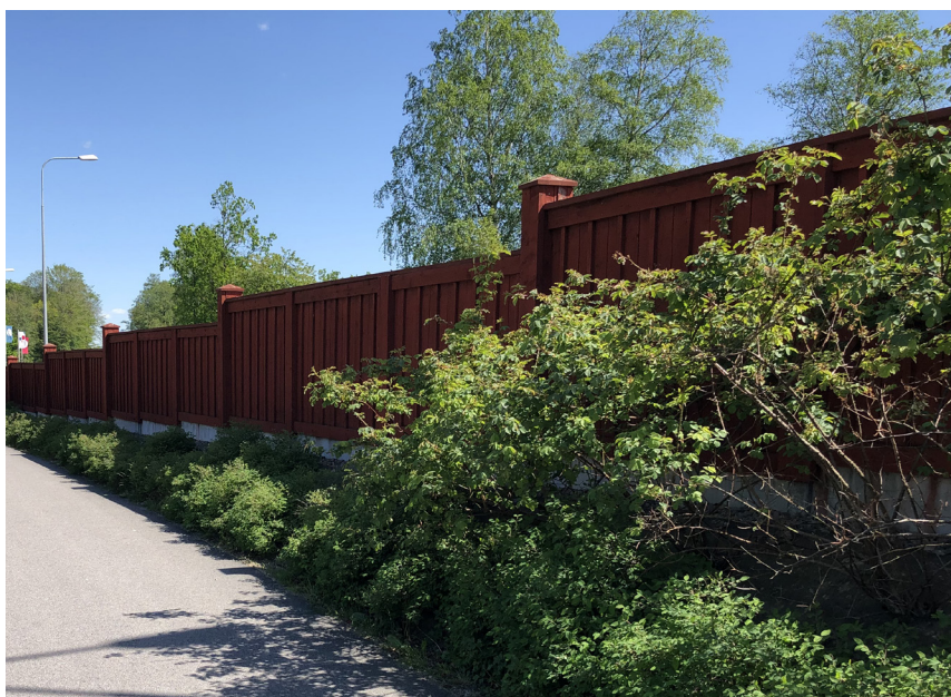
Bild 75. Bullervall och plank utmed Haganäsleden i Älmhult. Samma utformning utmed Danska vägen.
