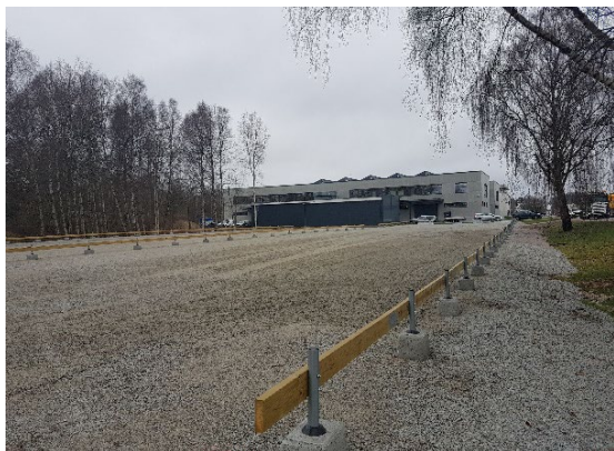
9. Södra delen av fastigheten Blåsippan 1 efter rivningen av lagerbyggnaden.
