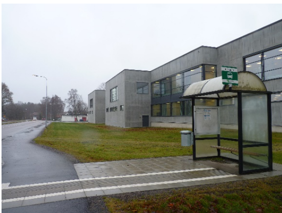
7. Busshållplatsen och den nya kontorsbyggnaden. Vy från Bäckgatan.
